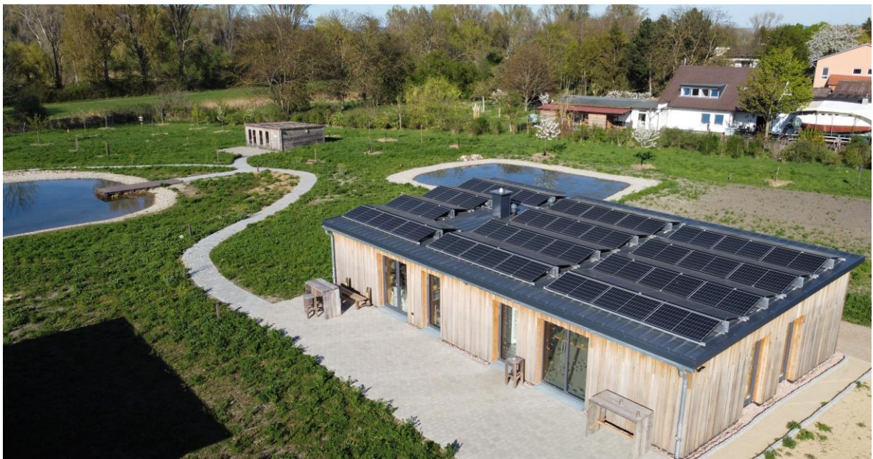
Abbildung 1: Neue PV-Anlage „NABU“
