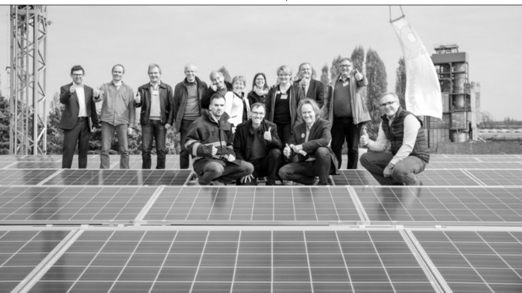
Eine der PV-Anlagen von Urstrom auf dem Dach der Firma RIGA in Mombach. Bildnachweis: UrStrom eG/S. Dinges
